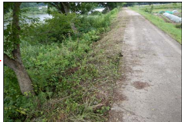
▲動線表示用ロープを撤去し、通行幅を確保しました。
