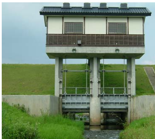
樋門、樋管・・・生活排水や雨水を堤防の中を通して河川に流すための施設
