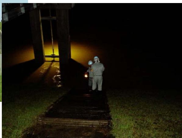
樋門、樋管・・・生活排水や雨水を堤防の中を通して河川に流すための施設
