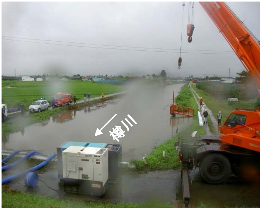
平成25年7月洪水時の状況
