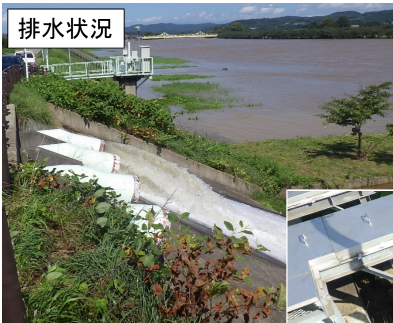
大曲川救急内水排水施設 最大排水量: 4\text{ m}^3/\text{s}
