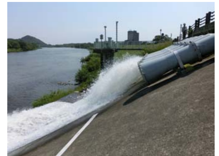
広瀬川排水施設の排水状況(試験運転)
