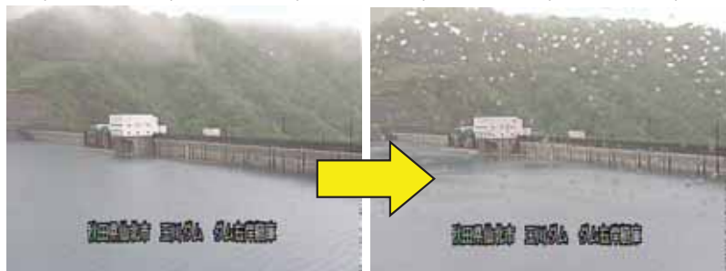
防災操作開始前の 貯水位 EL. 397.22m
