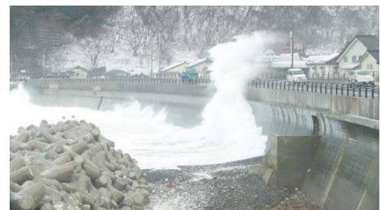
▲国道7号の越波状況
