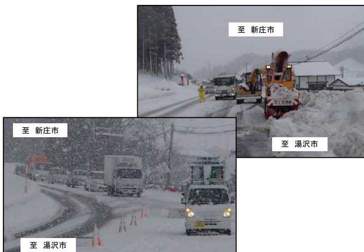
▲交通規制を伴う運搬排雪作業の状況(国道13号)
