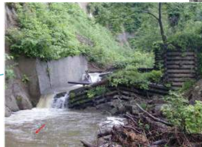
横道沢第1砂防堰堤損傷状況
