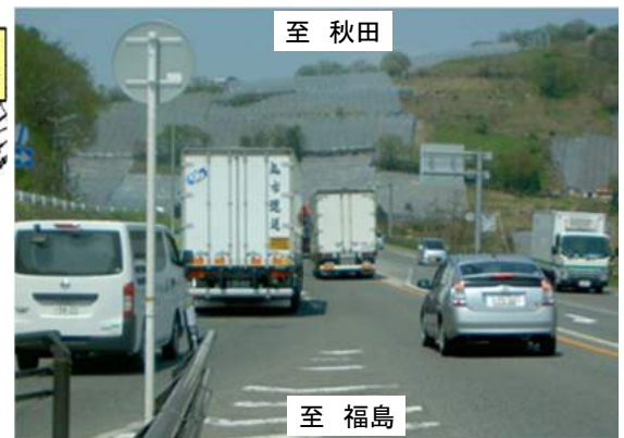
▲車両合流部の交通状況
