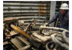
集水ボ-リング 施工状況
