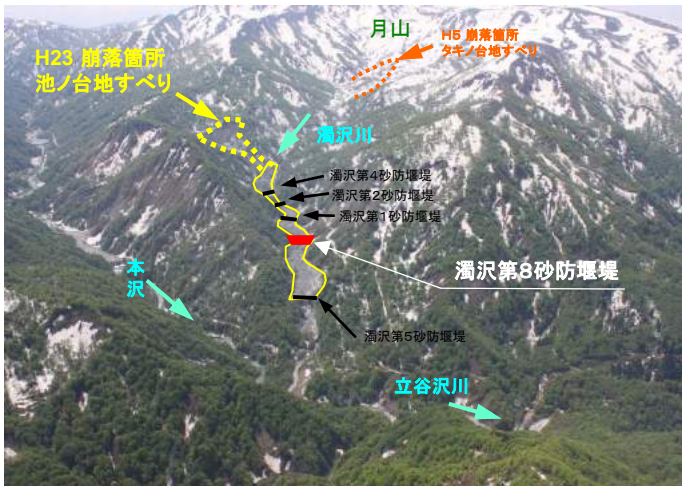
大規模崩壊後の立谷沢川流域濁沢
