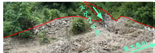
東大鳥川上流スゲブチ沢からの土砂流出状況
