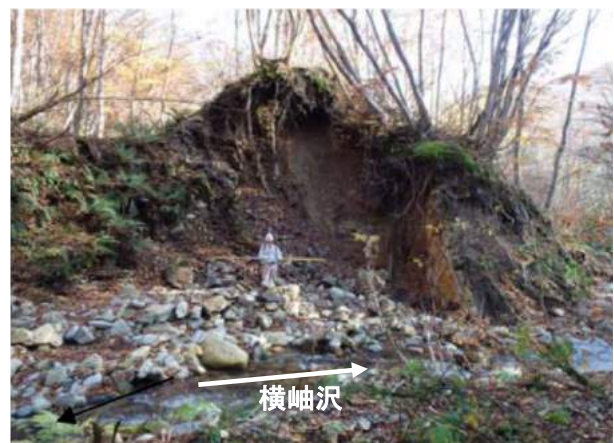
上流域の溪岸崩壊箇所
