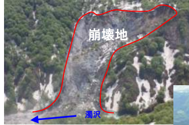
H23 崩壊状況
