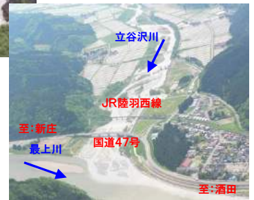
最上川合流点付近には土砂が堆積
