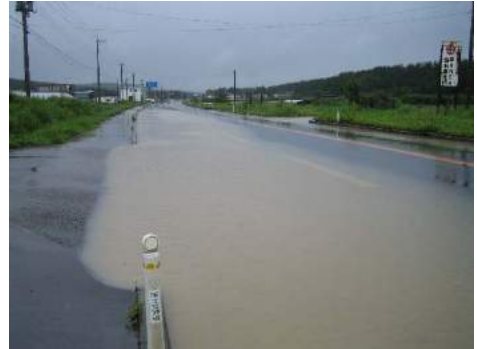
▲国道7号の冠水状況
