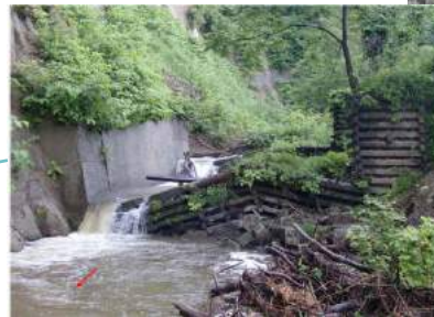
横道沢第1砂防堰堤損傷状況
