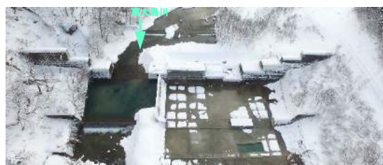
東大鳥川砂防堰堤
