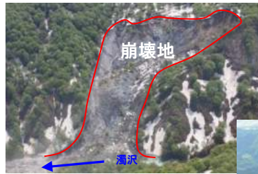
H23 崩壊状況
