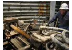
集水ボ-リング 施工状況
