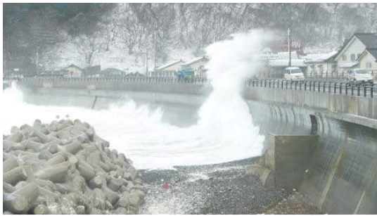
▲国道7号の越波状況
