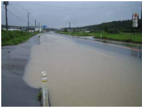
▲国道7号の冠水状況
