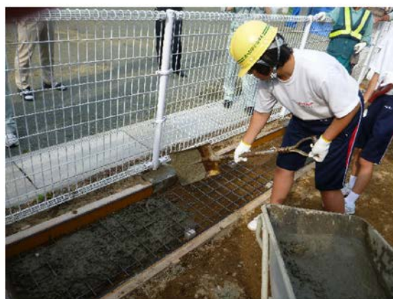
スコップでコンクリートを投入
