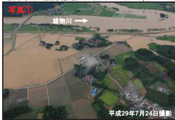
浸水状況(福部羅地区)
