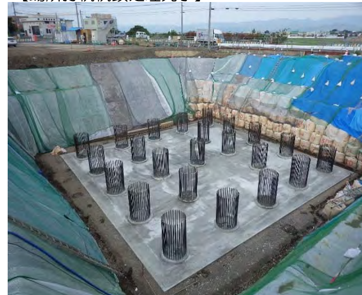
【場所打杭杭頭処理完了】
