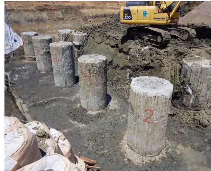
【場所打杭施工完了】
