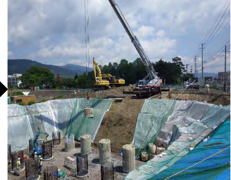
【場所打杭杭頭処理状況】
