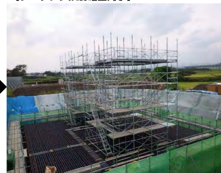
【フーチング鉄筋組立完了】
