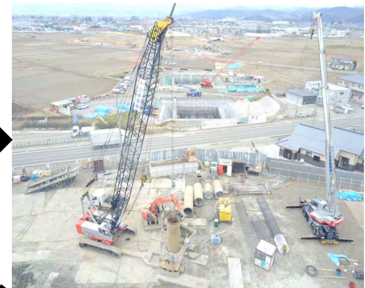
【場所打杭施工】
