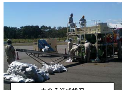
土のう造成状況
