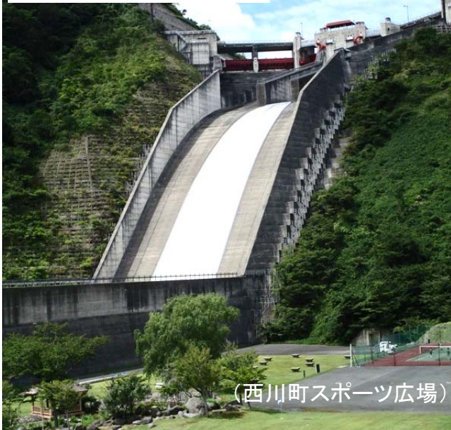
寒河江ダムゲート放流状況
