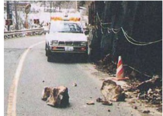
▲現道の落石状況
