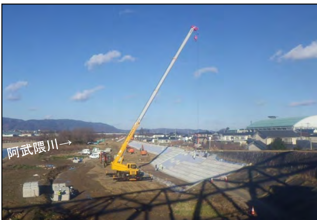
▲工事の進捗状況
