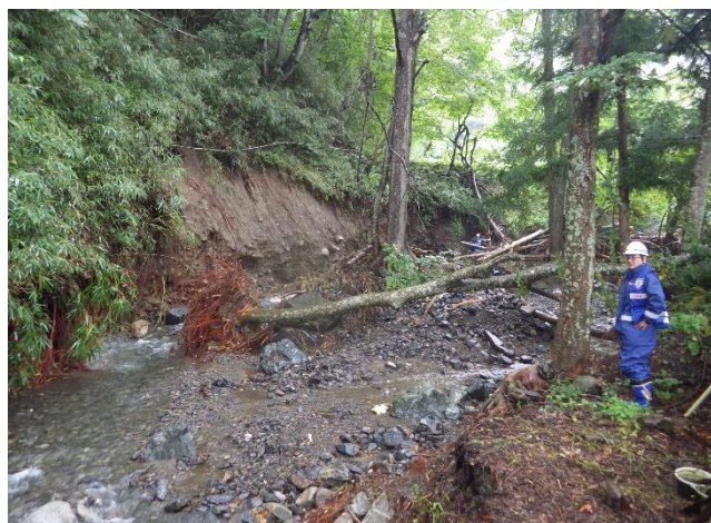
▲ 岩手県宮古市被災状況調査 （東北地整TEC-FORCE）
