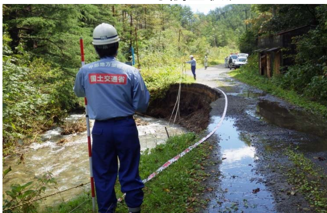
中部地整 道路調査班
