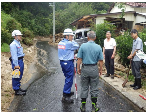
▲ 岩手県宮古市被災状況調査 （中部地整TEC-FORCE）
