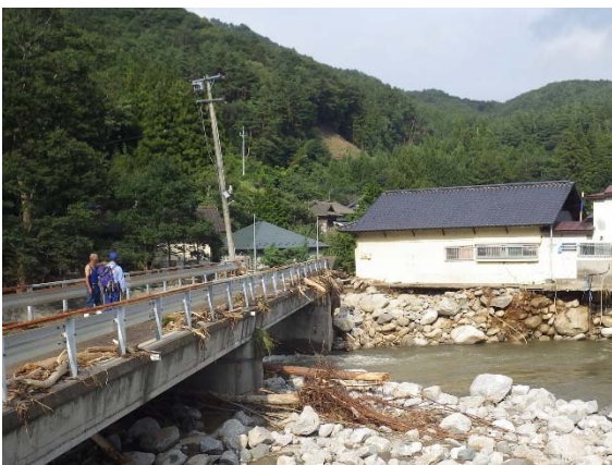
▲岩手県釜石市中村橋付近の被災状況聞き取り（中部地方整備局TEC-FORCE）
