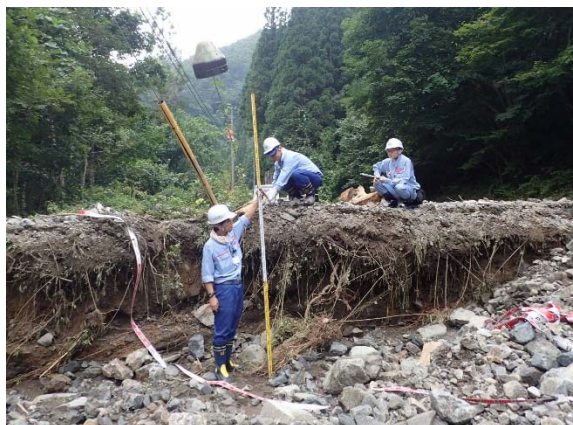
▲岩手県宮古市北川目地区における被災 状況調査（近畿地方整備局TEC-FORCE）
