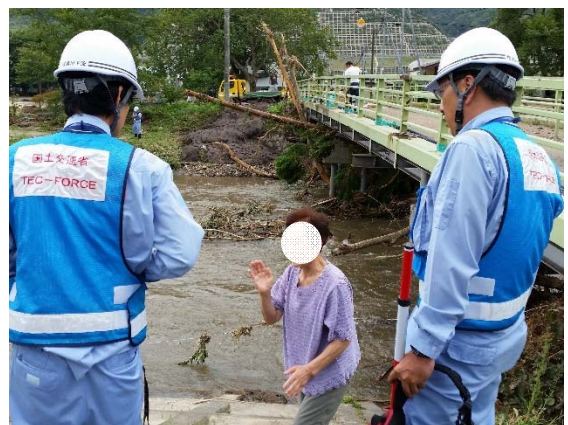
▲岩手県普代村羅賀橋付近の被災状況聞き取り（北陸地方整備局TEC-FORCE）
