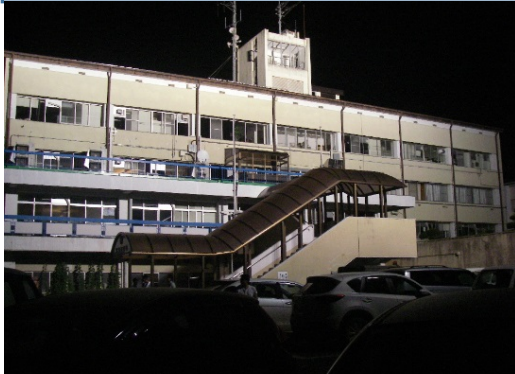
▲照明車による夜間照明作業
