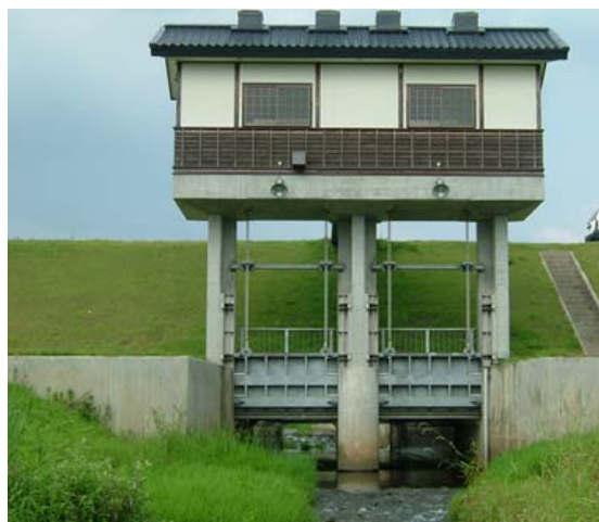
樋門、樋管・・・生活排水や雨水を堤防の中を通して河川に流すための施設
