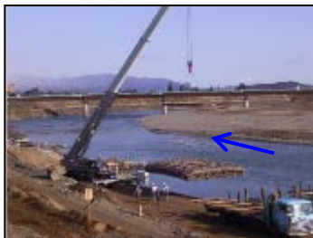
吊り込み状況
