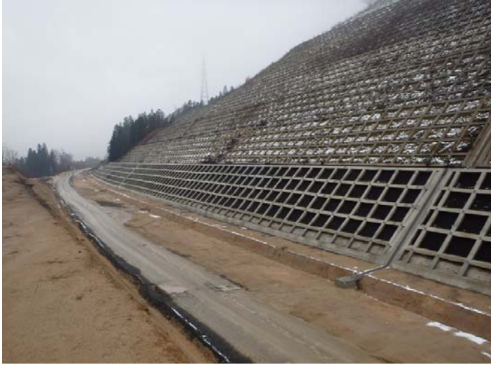
梓山地区道路改良工事:山和建設(株)
