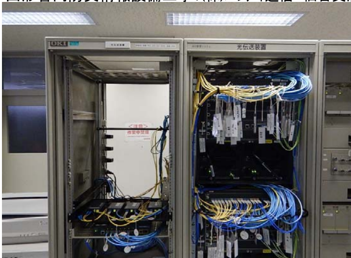
山形管内防災情報設備工事:(株)バンダイ通信 仙台支店
