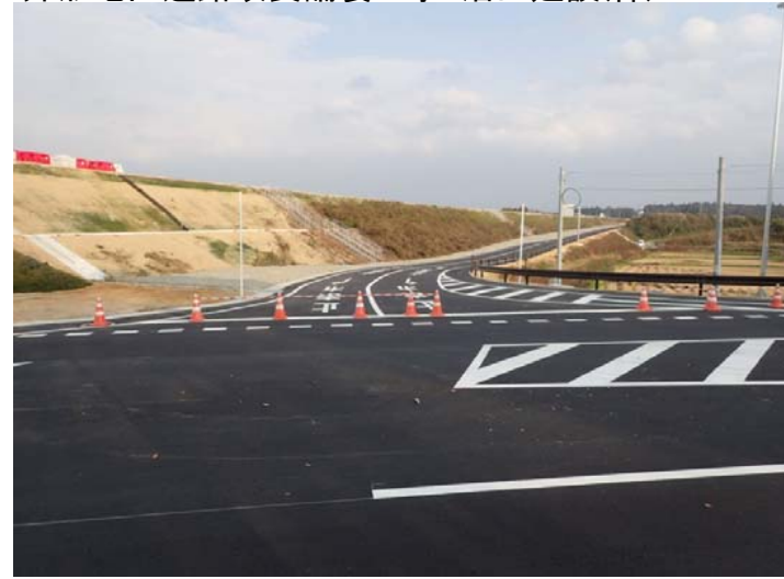
升形地区道路改良舗装工事:沼田建設(株)
