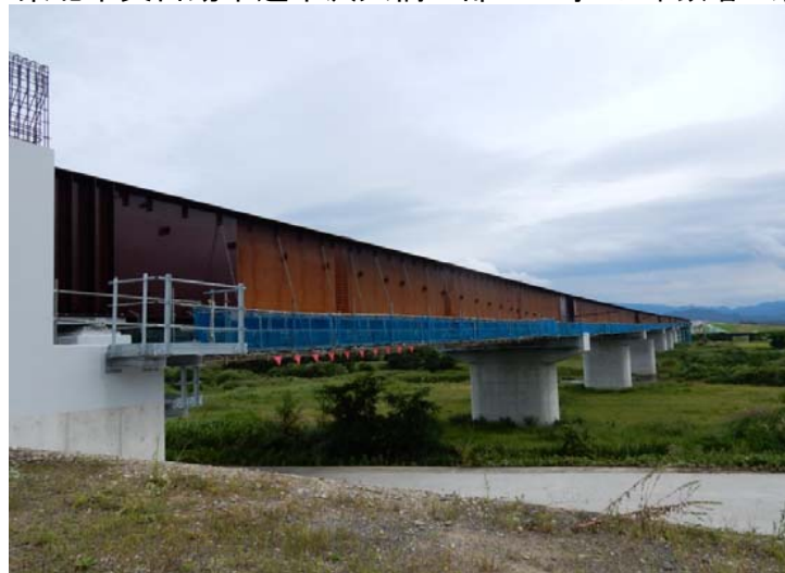
東北中央自動車道米沢大橋上部工工事:日本鉄塔工業(株)仙台営業所
