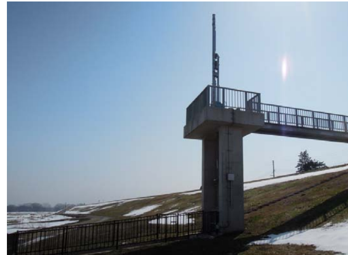
最上川上流水文観測施設設置工事:富士通ネットワークソリューションズ(株)東北支店
