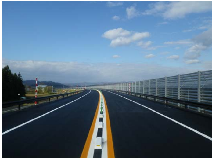
福宮地区舗装工事:(株)柿崎工務所
