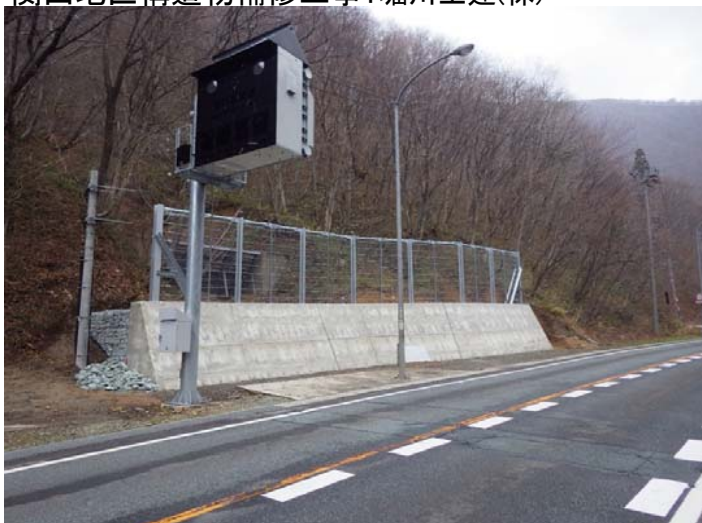
関山地区構造物補修工事:堀川土建(株)
