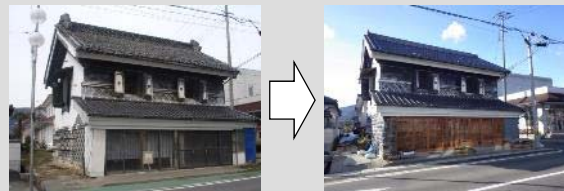
■歴史的建造物の修景イメージ
