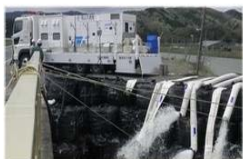
【東日本大震災での排水ポンプ車による排水活動】
