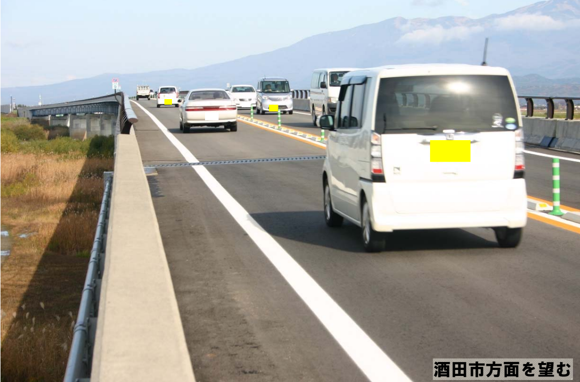
開通した余目酒田道路
