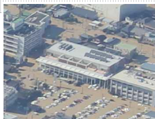
常総市役所の浸水の状況
