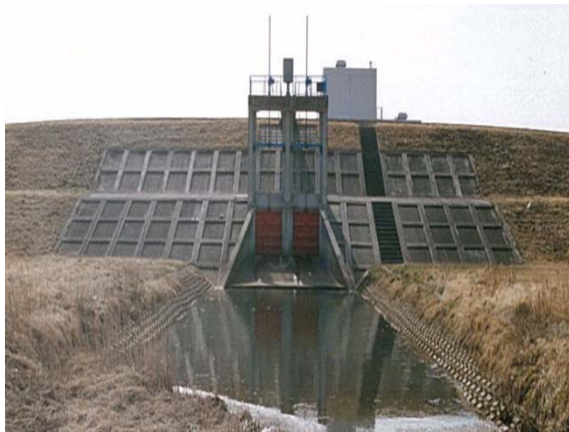
楡木排水樋管(新江合川右岸3.0km 大崎市古川楡木地内)
