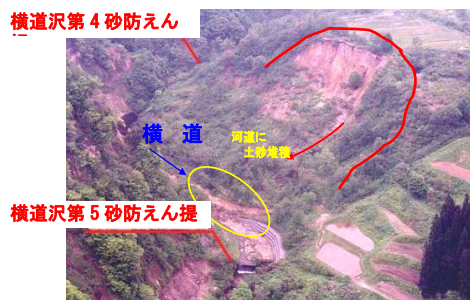
崩壊土砂の一部が横道沢に流出、河道を閉塞
