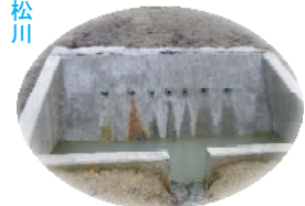
横ボーリング工
