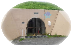
排水トンネル工（坑口）
