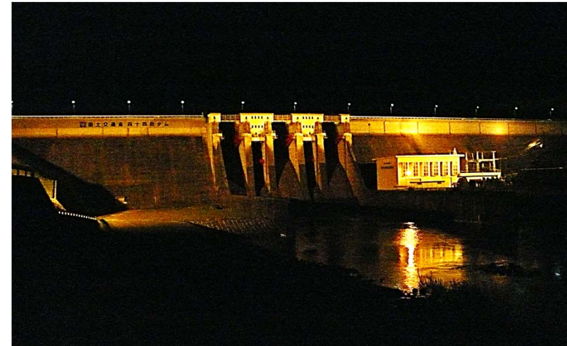
ダム堤体ライトアップの様子
