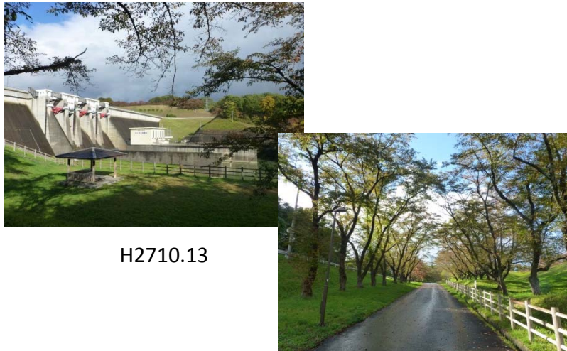
ダム下流東屋付近より
