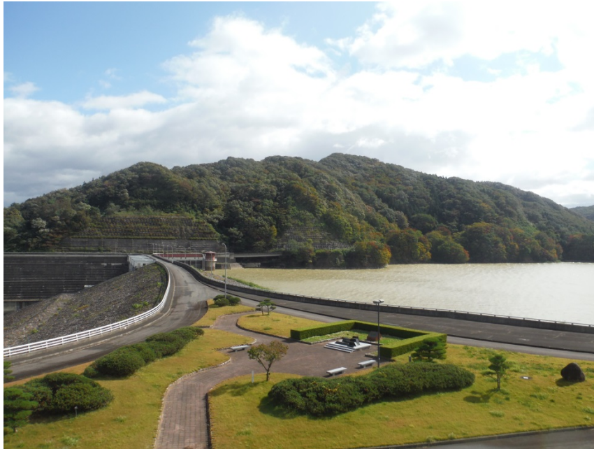
ダムサイト状況 H2710.9現在
