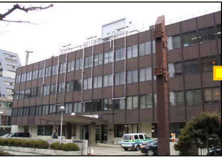
▼二日町庁舎外観
