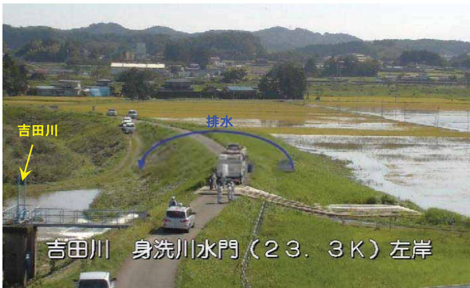
▲身洗川の排水作業状況（平成27年9月12日14時、身洗川水門）
