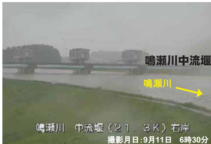
鳴瀬川 中流堰 (21.3k付近)
