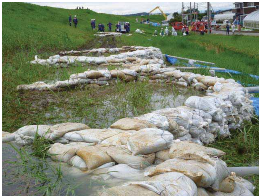
▲月輪工の完了状況
