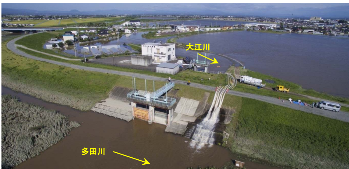
▲大江川の排水作業状況(平成27年9月11日16時、大江川排水機場付近)
