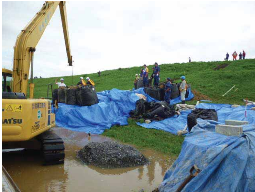
▲水防工法(月輪工)を実施
