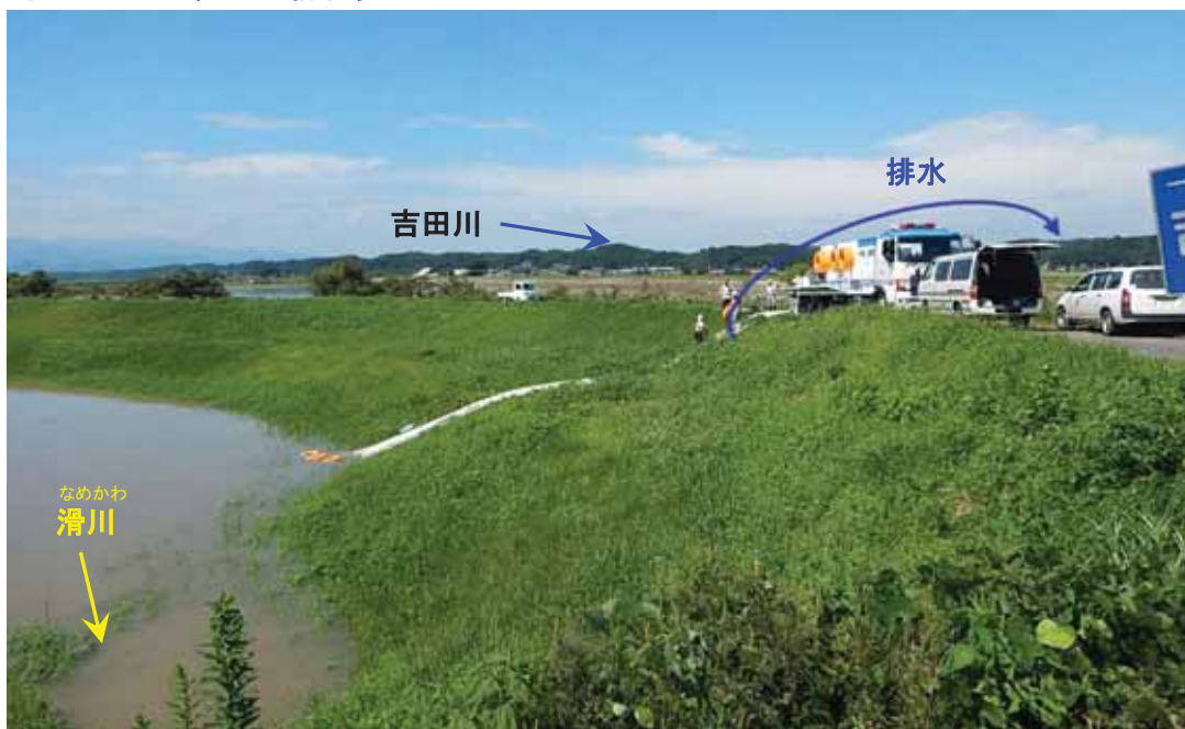
▲滑川の排水作業状況（平成27年9月12日11時、後谷地排水機場付近）
