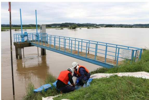
▲吉田川排水ポンプ設置状況 （平成27年9月11日13時）
