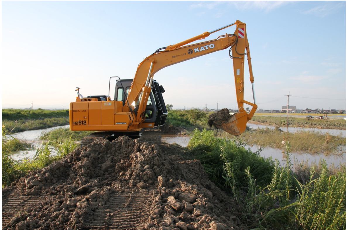
▲渋井川堤防応急復旧状況 (平成27年9月12日16時)
