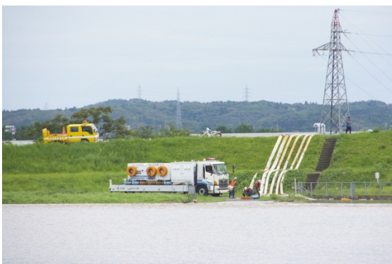
▲大江川排水作業状況② （平成27年9月11日16時）
