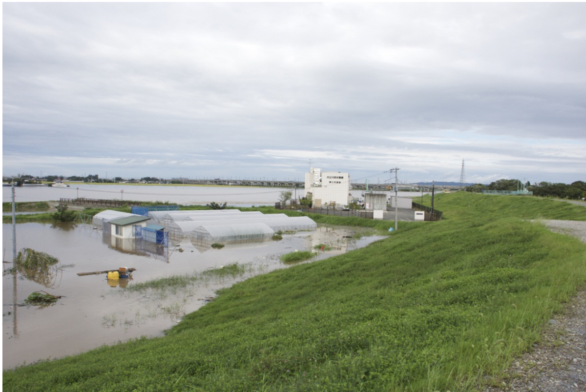
▲大江川出水状況（平成27年9月11日16時、大江川排水機場付近）
