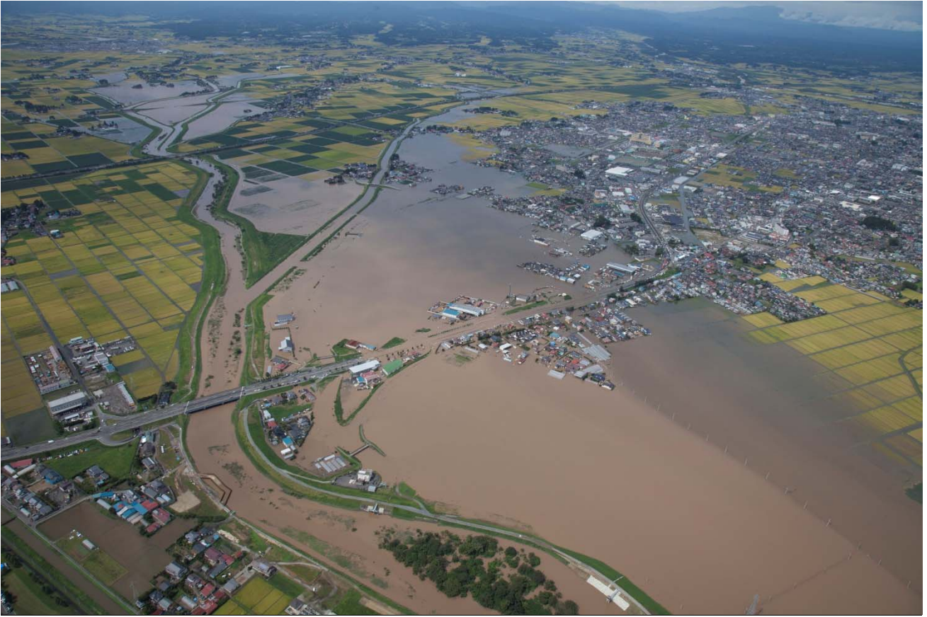
▲渋井川決壊状況（全景写真）（平成27年9月11日18時）
