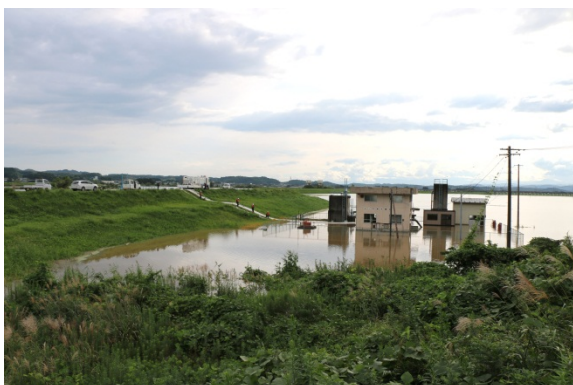
▲吉田川排水作業状況② （平成27年9月11日15時）
