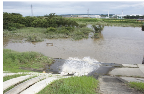
▲大江川排水作業状況③ （平成27年9月11日16時）
