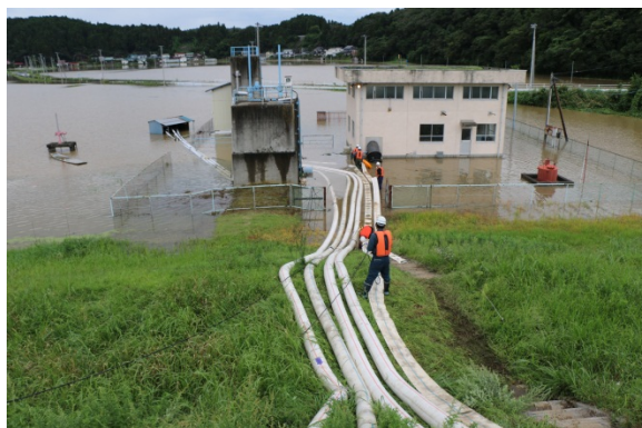
▲吉田川排水作業状況① （平成27年9月11日13時）
