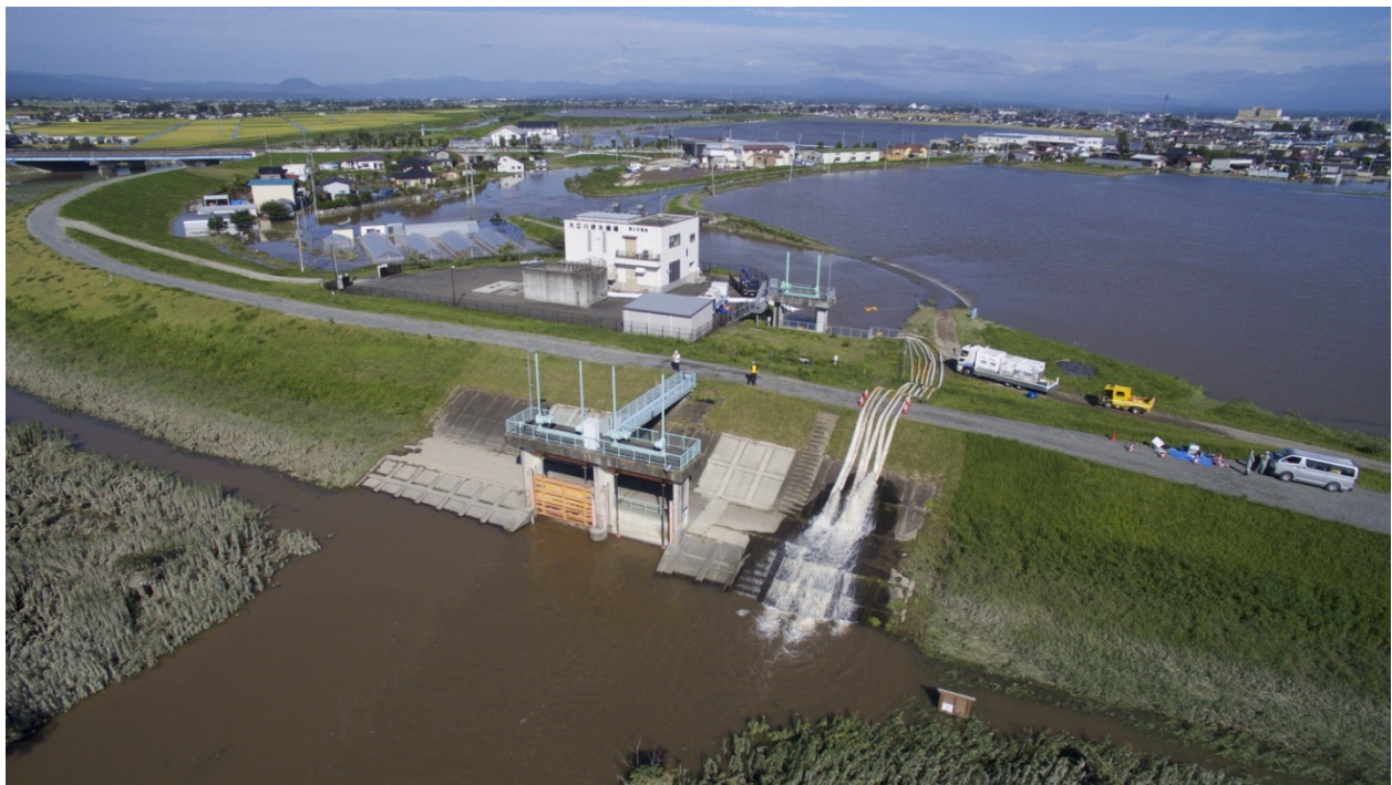
▲大江川排水作業状況④（平成 27 年 9 月 11 日 16 時、大江川排水機場）
