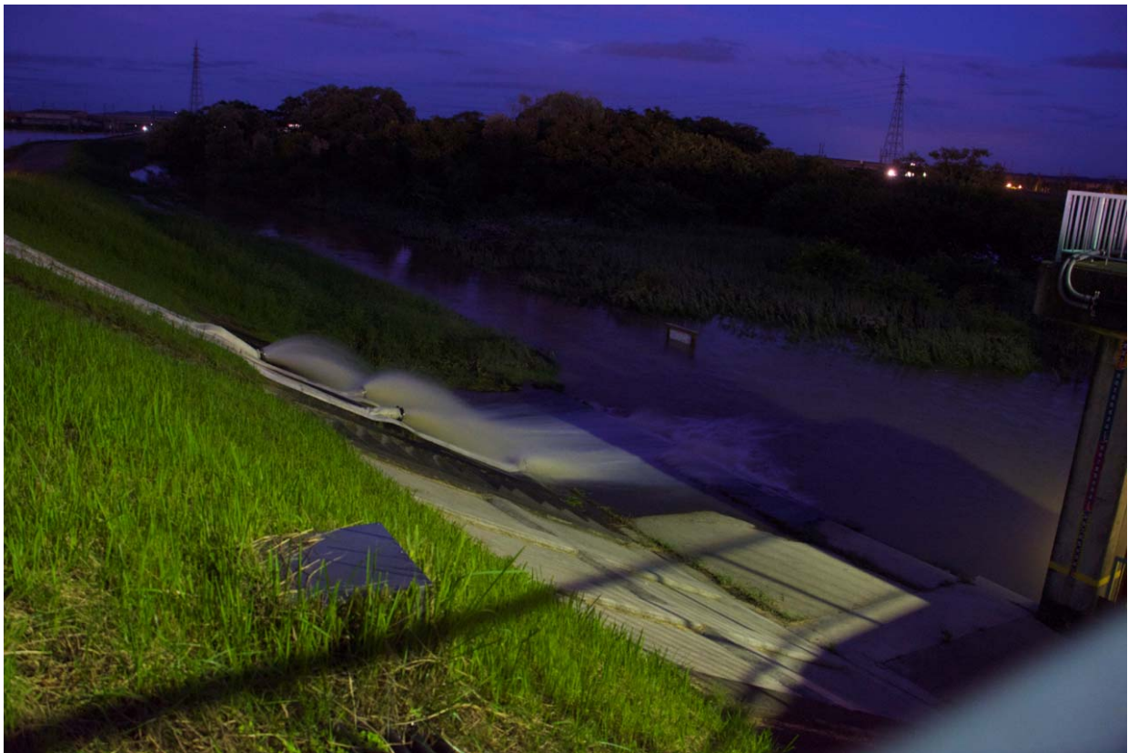
▲大江川夜間排水作業状況②（平成27年9月11日18時、大江川排水機場）
