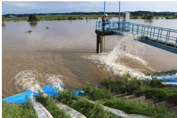
▲吉田川排水作業状況③ （平成27年9月11日16時）
