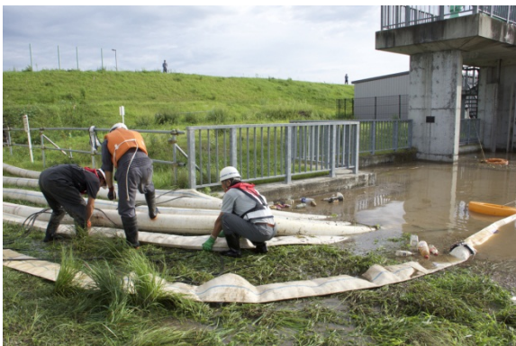
▲大江川排水ポンプ設置状況 （平成27年9月11日16時）
