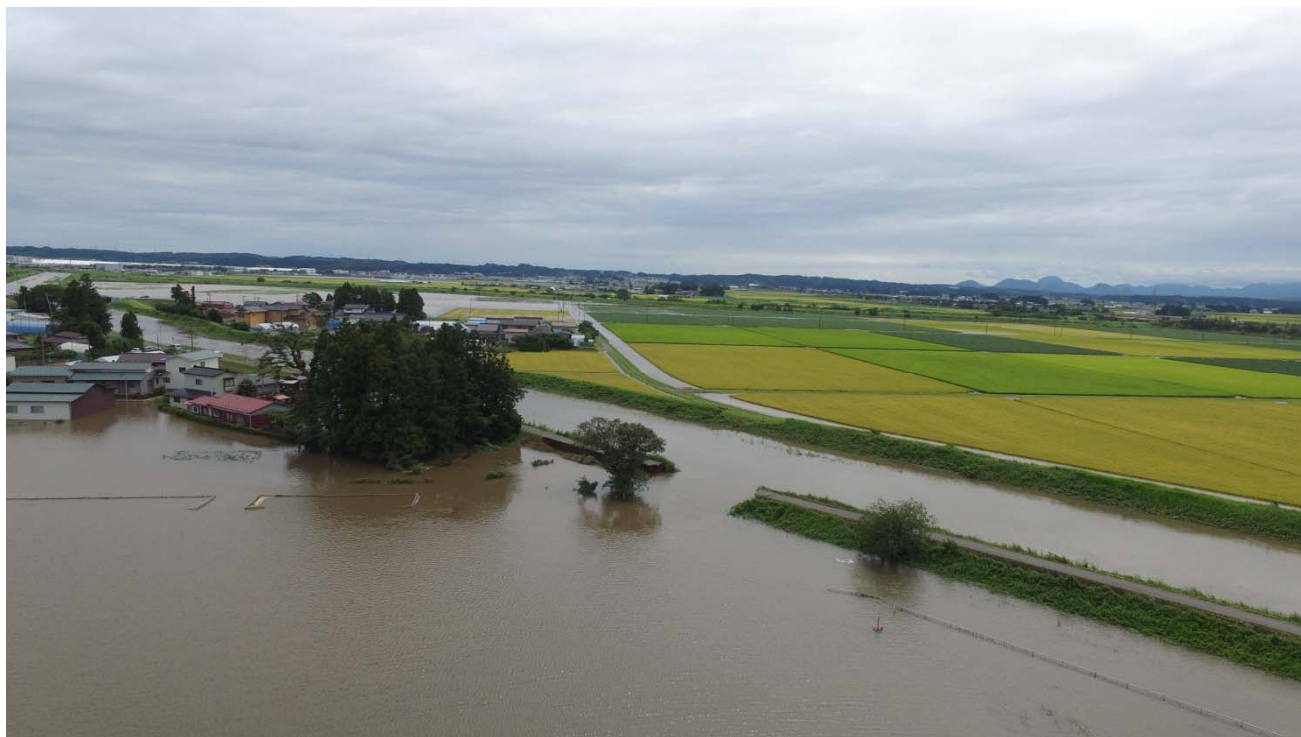
▲渋井川決壊箇所（近景写真）（平成27年9月11日12時）
