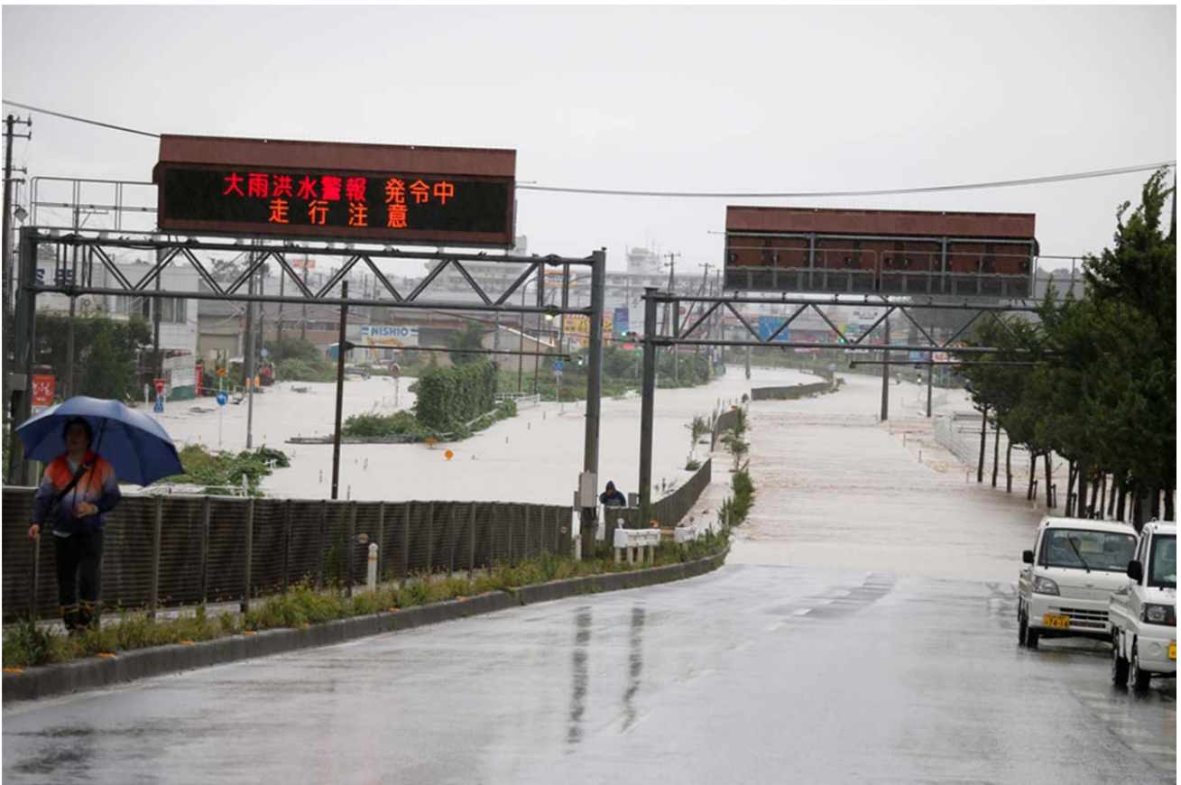
▲一般国道4号冠水状況（平成27年9月11日17時、古川米袋地内）
