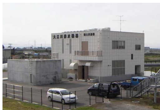
②大江川排水機場
