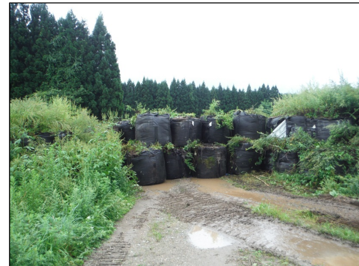
大型土のう126袋(延長約50m)を設置(9月11日8時40分 設置完了時)
