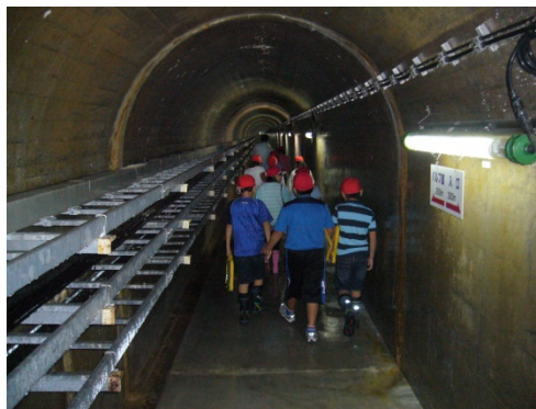
(監視廊内の点検)
