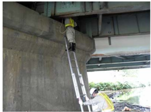
（橋梁点検状況写真）
