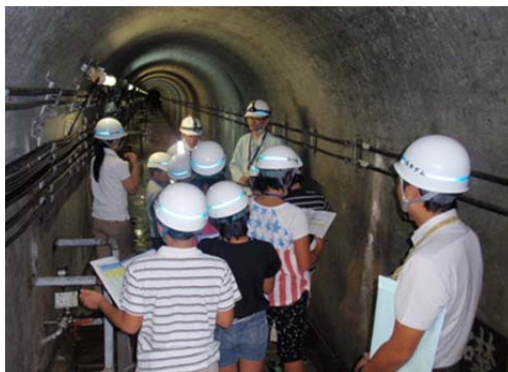
（監査廊内で点検計測）
