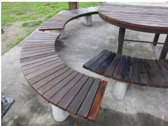
(措置後)ベンチの補修
