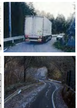
▲幅員狭小・線形不良状況
