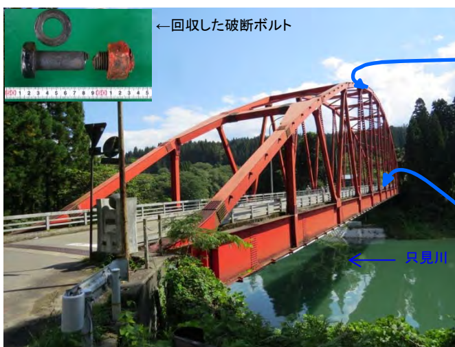
▲三島大橋 全景
