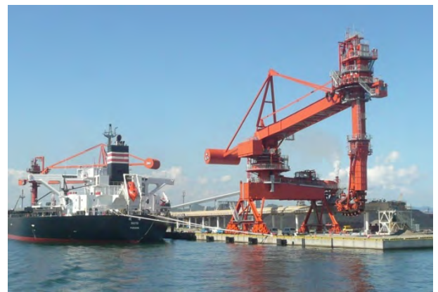
▲石炭運搬船による荷役状況
