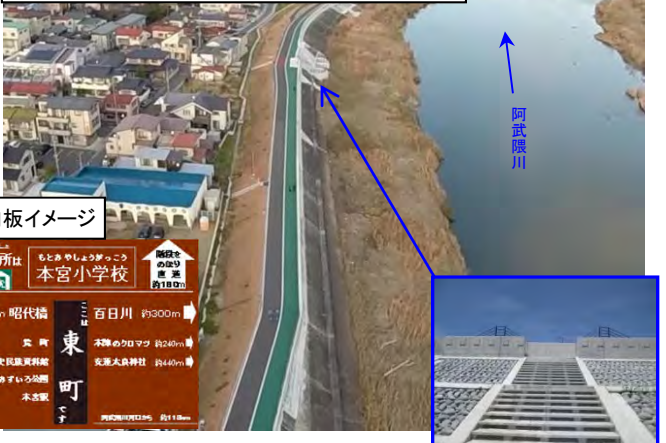
完成した堤防と水辺に近づく階段
