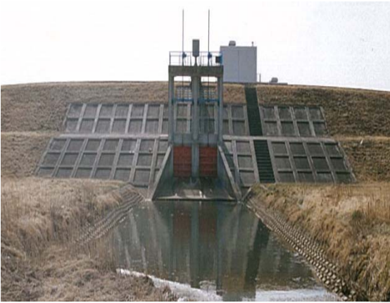
楡木排水樋管(新江合川右岸3.0km 大崎市古川楡木地内)
