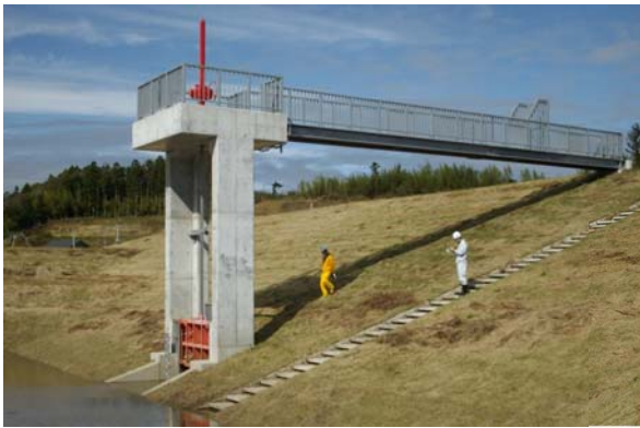
十階松排水樋管(鳴瀬川左岸5.8km 東松島市西福田地内)
