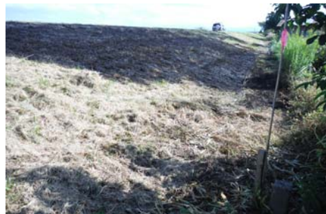
平成26年10月2日赤川左岸で発生した野火跡
