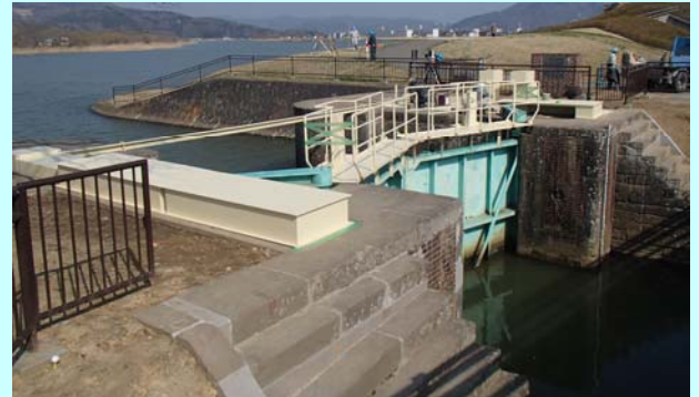
補修完了後の石井閘門 H26年3月28日
