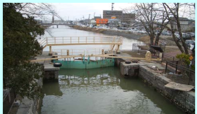
震災直後の石井閘門 H23年3月14日
