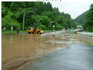
▼ 写真 大雨による通行止め状況 (H16/7/17)
