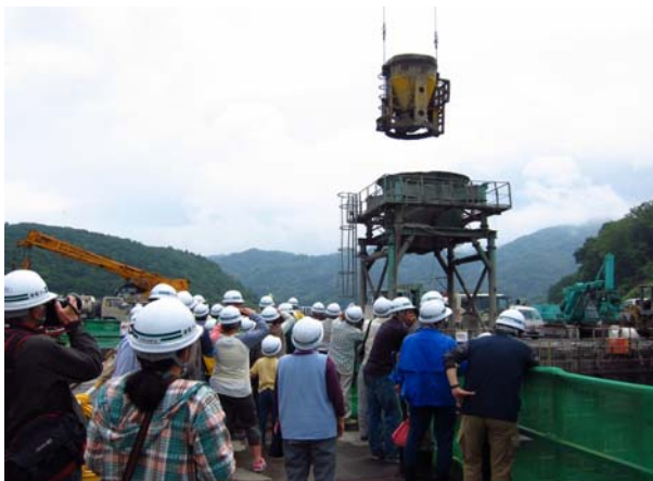
本体近くの目屋ダムに据え付けた仮設構台からは打設作業現場がすぐ間近に見られました
