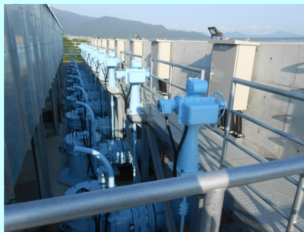
1m 3 /s × 10台で小水量でも効率的な台数制御が可能となったポンプ
