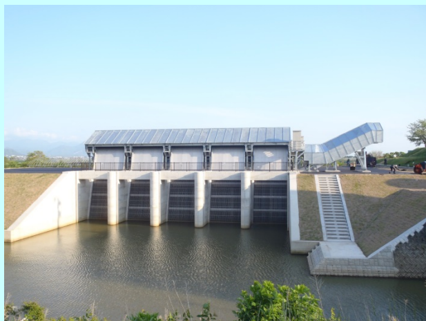
新川から見た新しい排水機場
