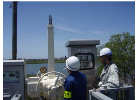
【昨年度点検の様子：吹越排水樋管】
