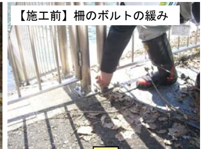
【施工前】柵のボルトの増締め
