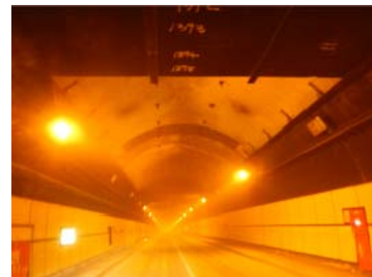
天井板撤去後の状況
