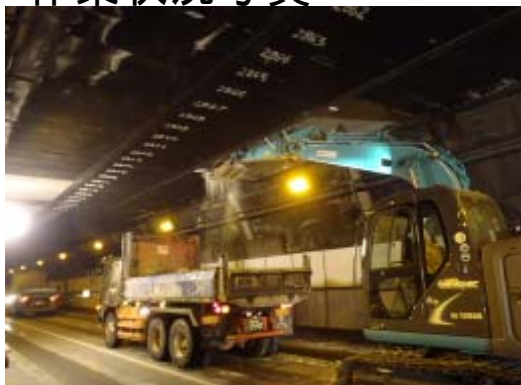
天井板撤去状況
