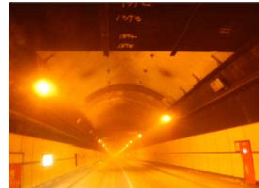
天井板撤去後の状況
