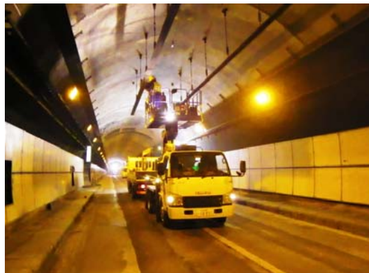
吊り金具撤去状況
