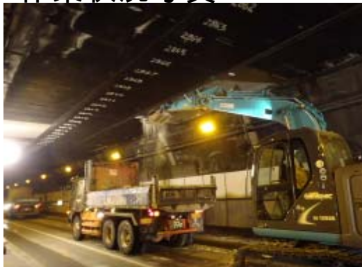
天井板撤去状況
