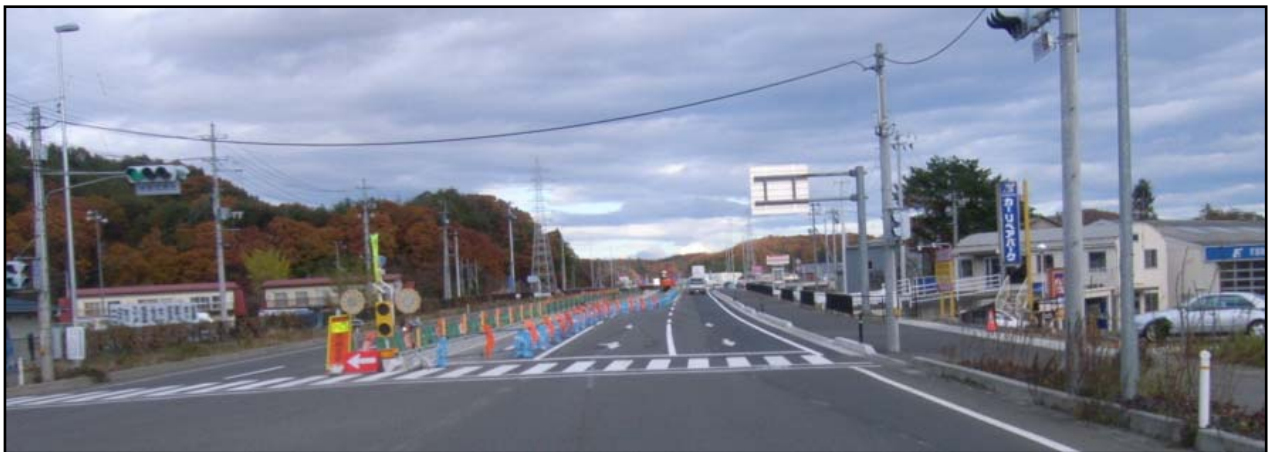
▲白河橋付近の現在の工事状況
