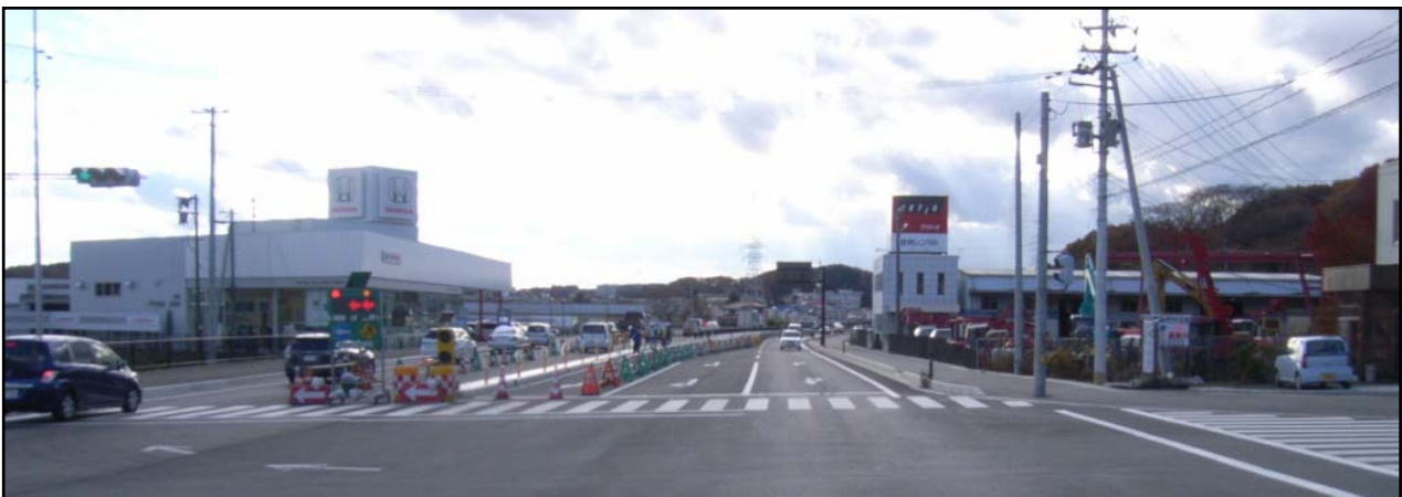
▲国道4号・(市)道場小路金勝寺線交差部の現在の工事状況
